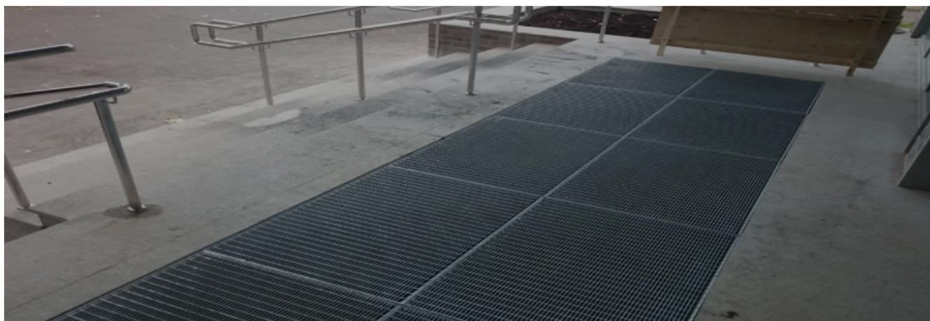
Стальные настилы - материал из несущих и покровных стальных полос, соединённых между собой в определённой конфигурации. Несущие полосы принимают на себя основную нагрузку, а поперечные полосы являются соединяющими. Большинство типов решётчатых настилов имеет обрамление из стальной полосы.
